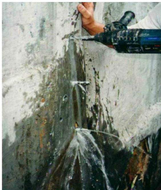
Рисунок 5 – Установка иньекторов
