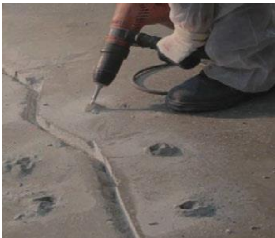
Рисунок 3 – Бурение отверстий для установки инъекторов
