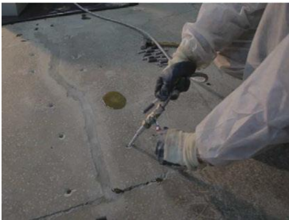
Рисунок 4 – Выполнение инъекционных работ
