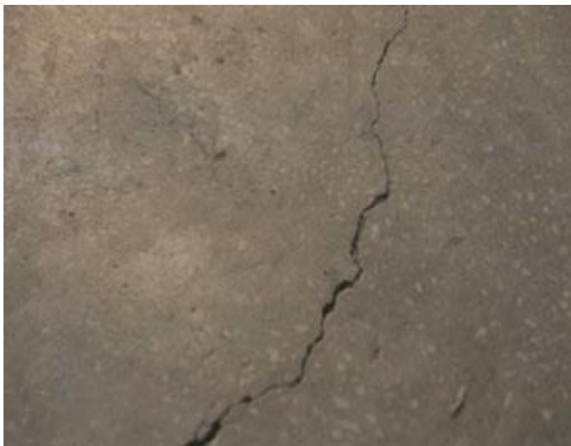
Рисунок 1 – Подвижная трещина. Общий вид
